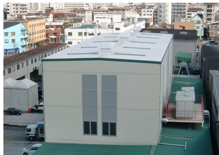
工場屋根に断熱塗装
